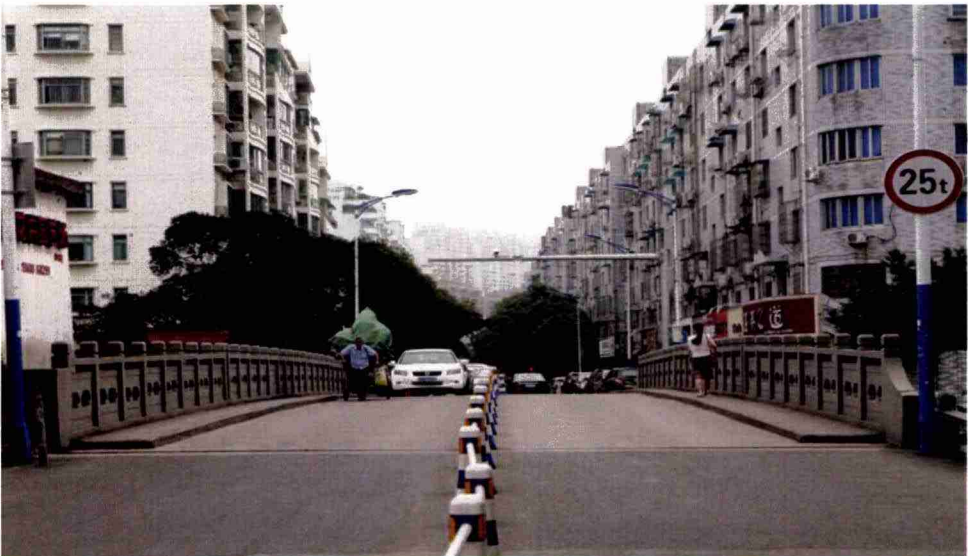
今之【葉星橋】西元 1994 年（民國 83 年）4 月立 捐建鋼筋混凝土公路橋樑，原意為【四線車道+二人寬 人行專用步道+腳踏車專用步道】，工程完工卻縮水
