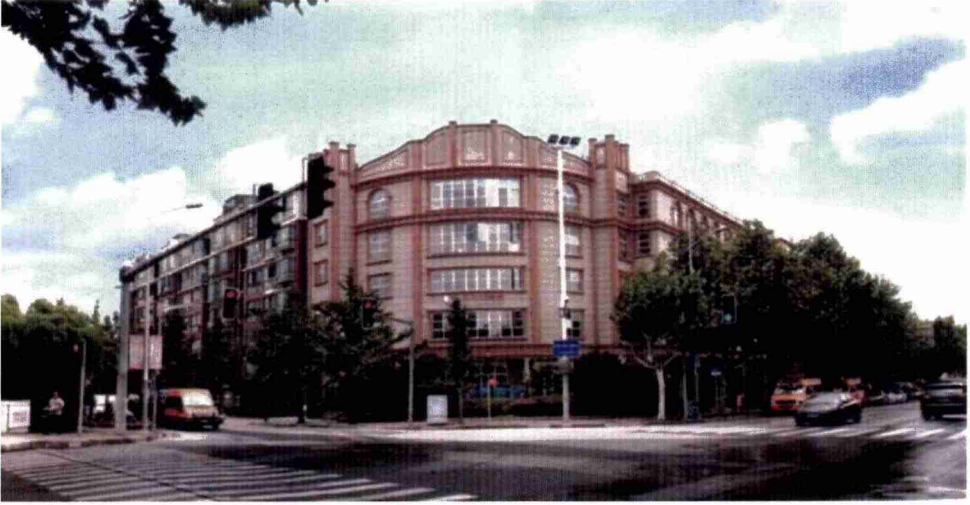
上海市長寧區「貝爾幼稚園」園區完工全景 總建築為五層樓，每層 1,000 平方米
