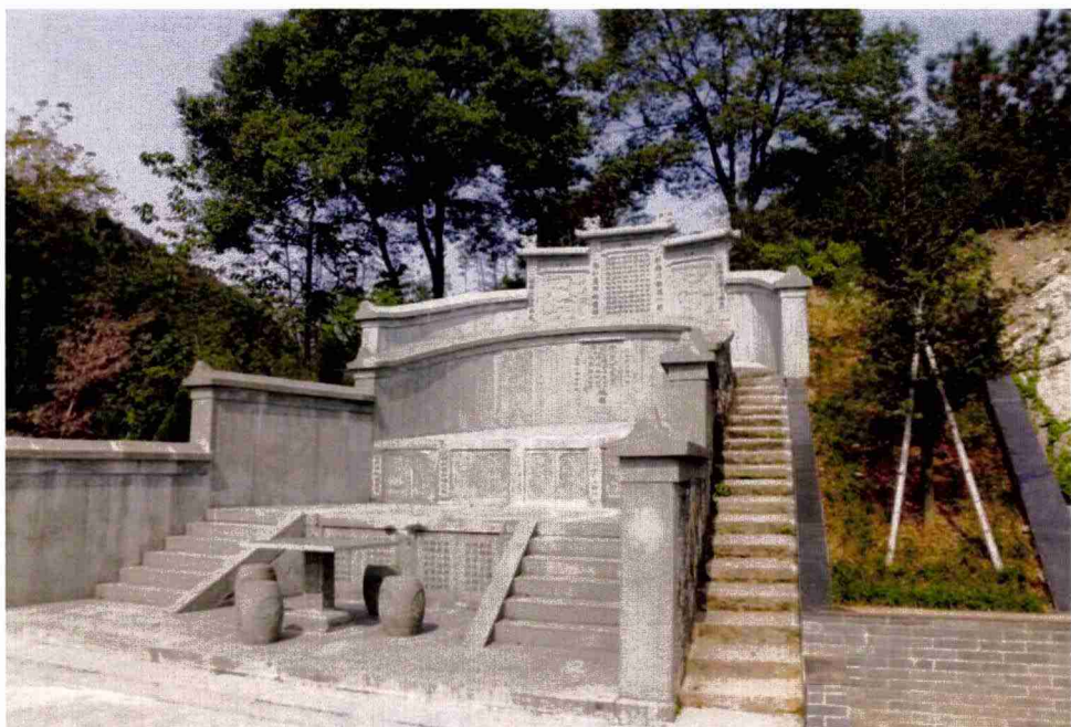
楊府山文保葉學程公之墓 - 第二期工程修建墓園總高四層
